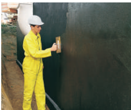
Hüdroisolatsiooni Superflex 10 pinnale kandmine
