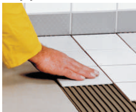
Plaatide paigaldamine Plastikol KM Flex-iga.
