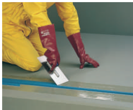
Hüdroisolatsioonilindi kleepimine deformatsioonivuugi ehitamiseks Superflex 40 S-ga
