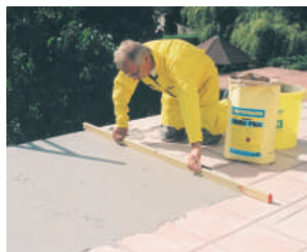
Tasanduskihi tegemine vanale plaadistusele Plastikol KMH Flex-iga
