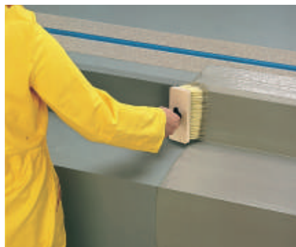
Hüdroisolatsiooni Superflex D1 pinnalekandmine pintsliga
