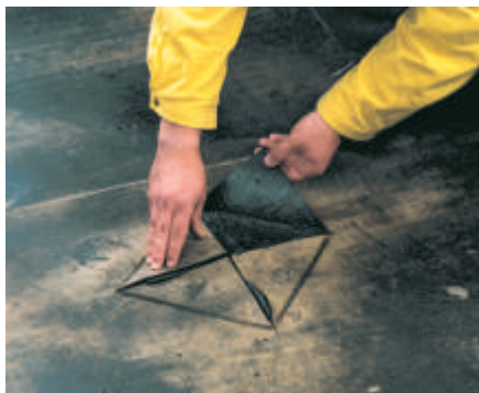
Vett läbilaskev koht avatakse kogu kahjustunud osa ulatuses. Seejärel keeratakse lahtise katusekatte servad üles
