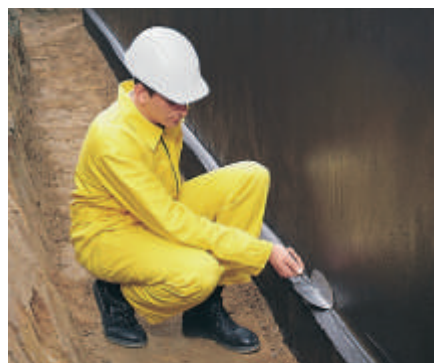
Hüdroisolatsioon tuleb kanda kuni vundamenti taldmikuni. Kumera nurga tegemiseks kasutatakse spetsiaalset kellut.
