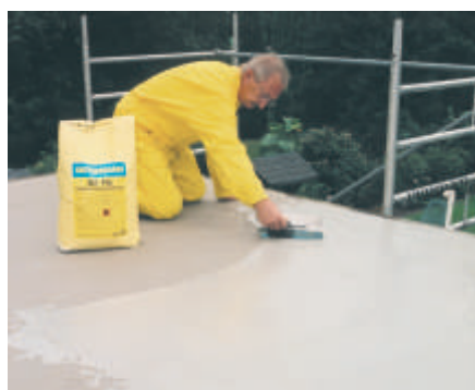
Hüdroisolatsioonikihi tegemine kiirelt kuivava Deitermann DS Fix-iga.
