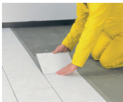
Plaatide paigaldamine
