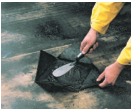
Purunenud kohale kantakse 1 kiht Plastikol 1, kihipaksus 3...4 mm, ning seejärel surutakse üleskeeratud kattematerjali servad parandusmastiksisse.
