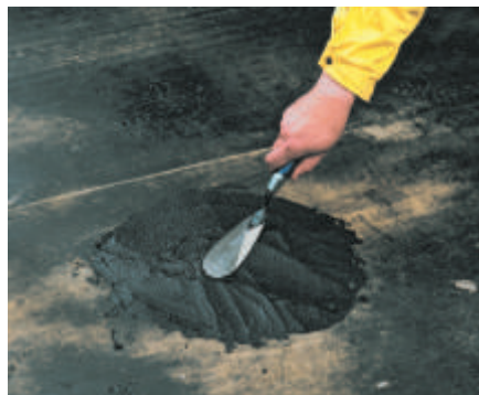
Parandatud kohale kantakse veel üks kiht Plastikol 1, kihi paksus ca 4...5 mm.
