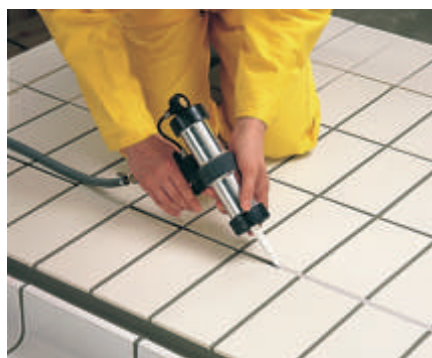
Elastsete vuukide täitmine silikooniga Plastikol FDU
