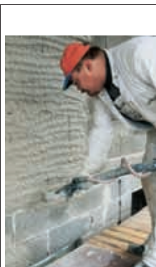
FIBO PLOKKIDEST SEINA TASANDAMINE PUMBAGA
