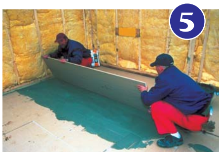
5. Esimesele kihile asetatakse teine, tugevam kiht aluspõrandaplaate. Plaadikihid tuleb omavahel liimida. Minimaalne vuukide vahekaugus on 20 cm.
