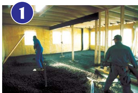
1. Pinnasele paigaldatakse Fibo kergkruusa fraktsioon 10...20 mm. Paigaldamine võib toimuda näiteks puhuriga, nagu pildil. Kohe toimub ka kergkruusakihi esialgne silumine.
