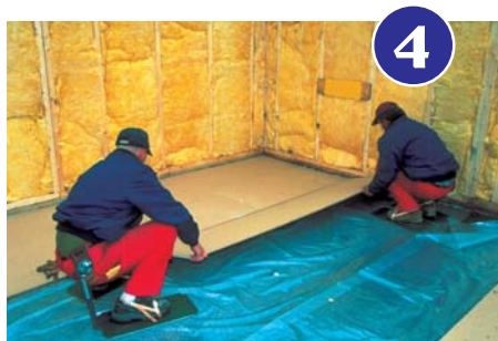
4. Asetatakse esimene kiht aluspõrandaplaate otse kilele, tihedalt teineteise kõrvale.
